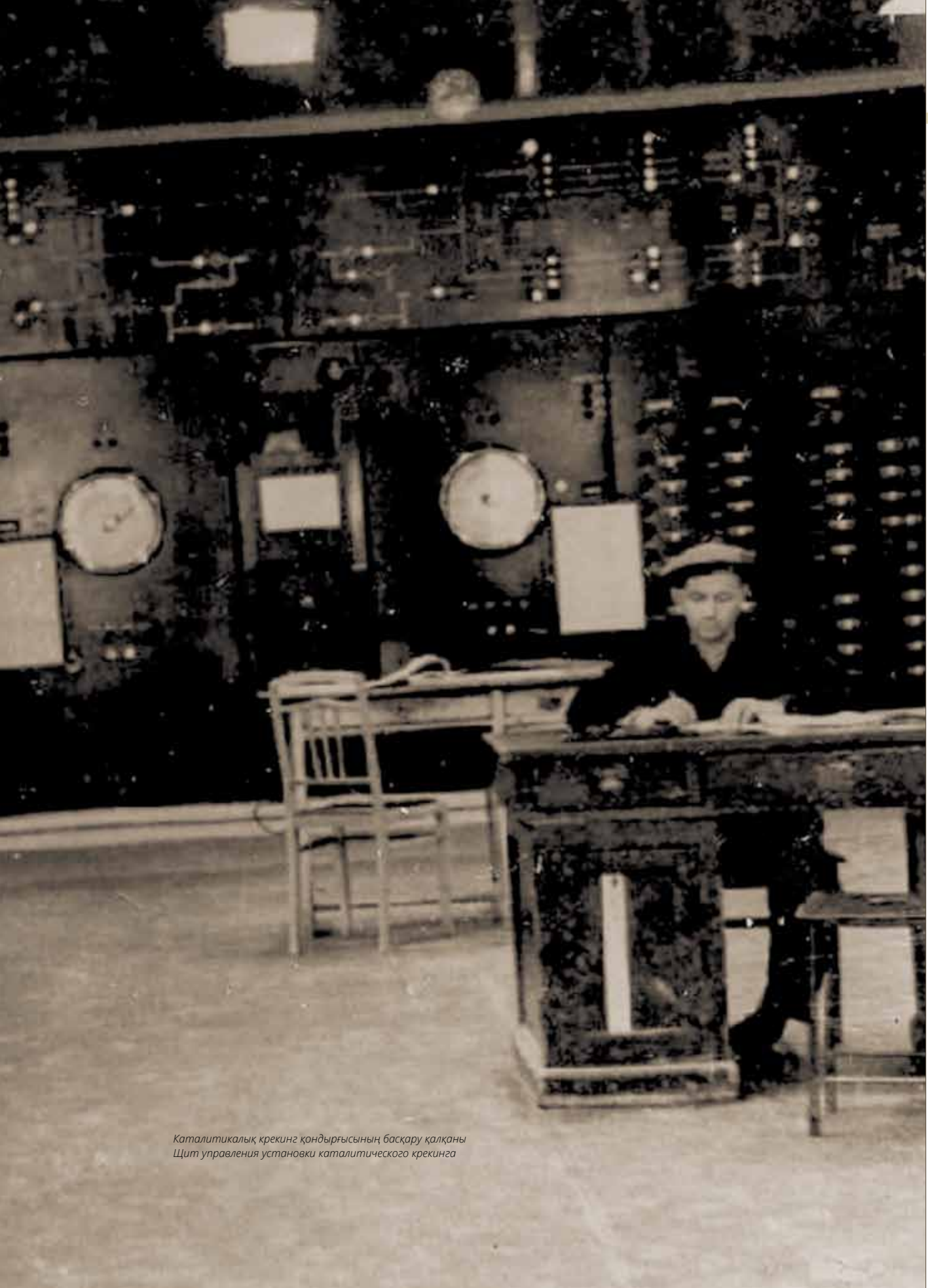
Гудри қондырғысының операторлық бөлмесі Операторная установки Гудри
