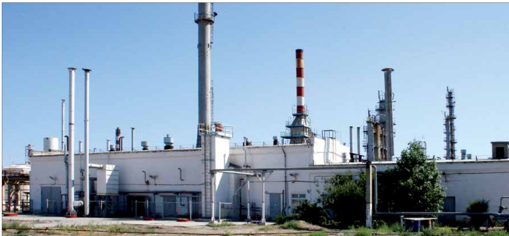
Техникалық азот шығаратын қондырғы Установка по производству технического азота
