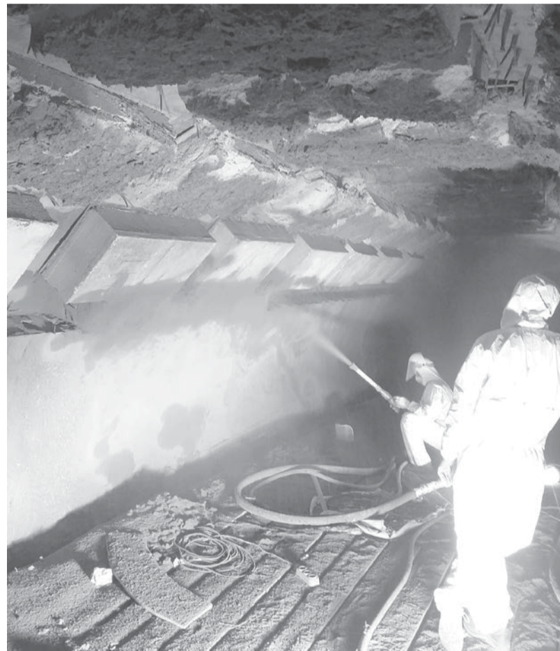
Футеровочные работы внутри печи
