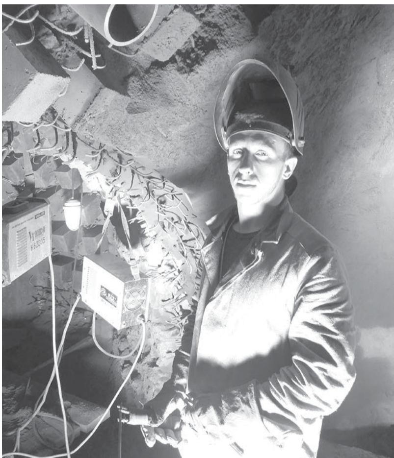
Сварка анкеров внутри печи
