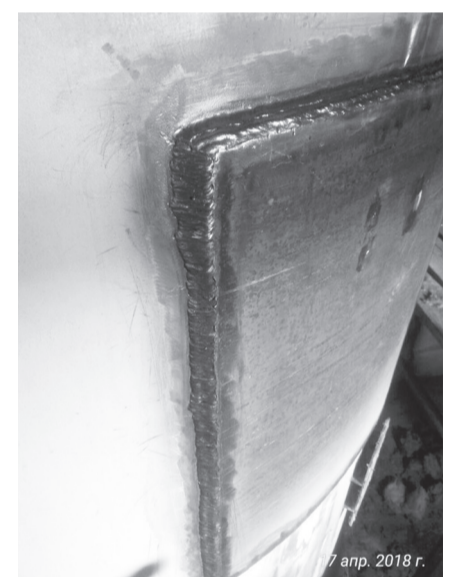
Пример ремонта сквозной коррозии (Адсорбер R-001C УПОВ)
