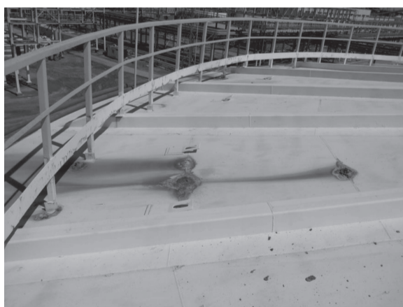
Коррозия по причине высокого содержания сероводорода (PBC-123 РП-31)
