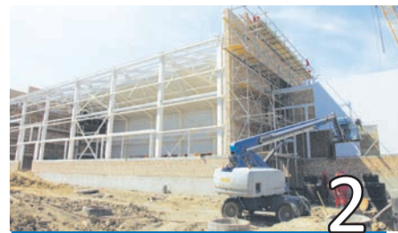
2 СТРОИТЕЛЬСТВО КГПН: КОНДЕНСАТНАЯ СТАНЦИЯ
