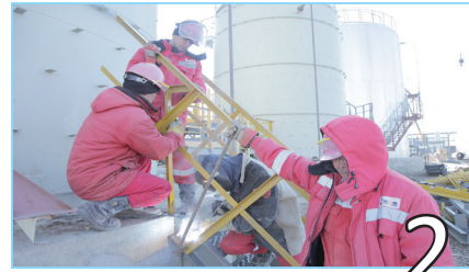
2 СТРОИТЕЛЬСТВО КОНДЕНСАТНОЙ СТАНЦИИ ДЛЯ КГПН
