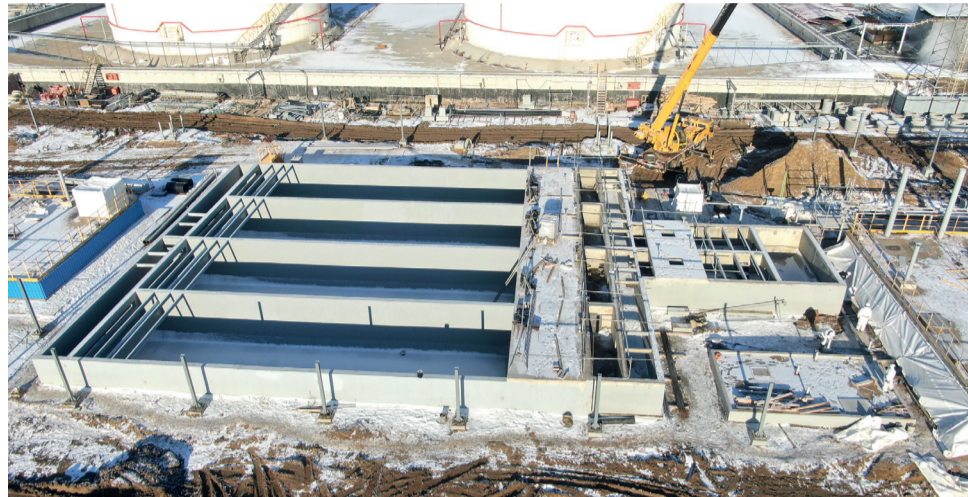
На фото: вид со строительства МОС
