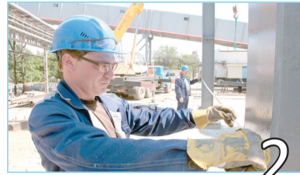
2 СТРОИТЕЛЬСТВО ГРАДИРНИ НА УЗК
