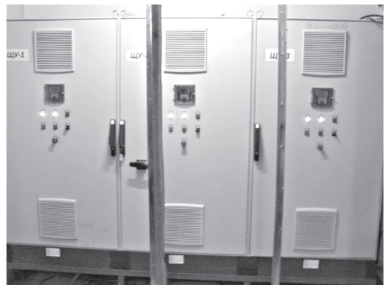
3-х частотные преобразователи фирмы «Schneider Electric»
