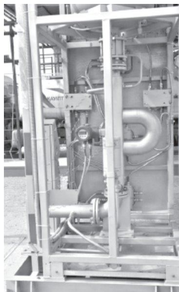
Автоматизированная система налива нефтепродуктов в автоцистерны компании «YOKOGAWA»
