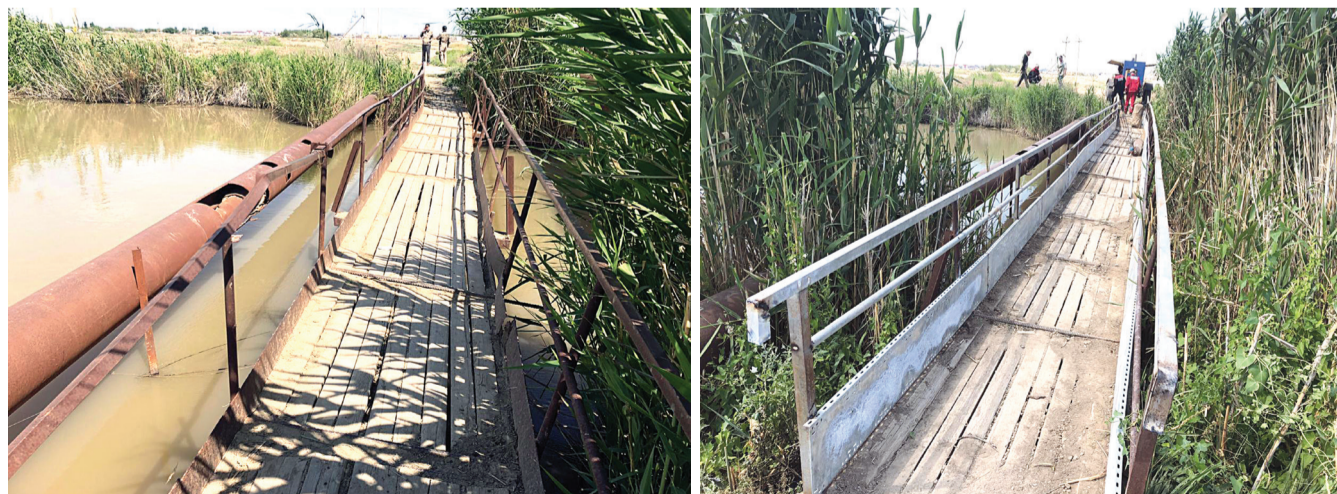
На фото: мост до и после ремонта
