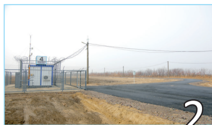
ДО СТАНЦИЙ – НОВАЯ ДОРОГА
