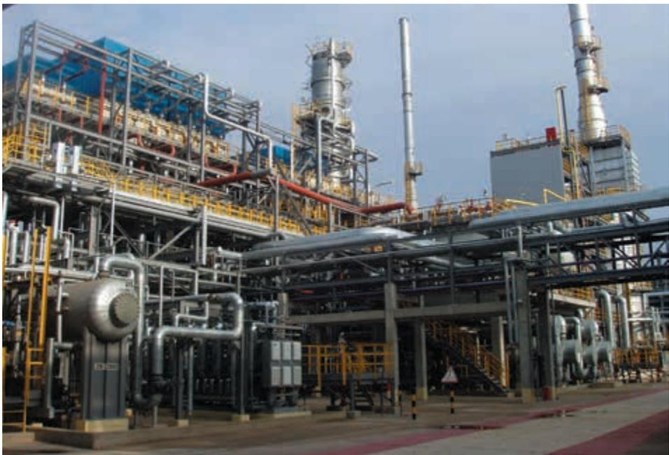
*Установка гидроочистки бензина и дизельных топлив*
