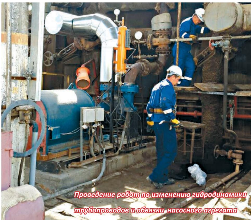
**Проведение работ по изменению гидродинамики трубопроводов и обвязки насосного агрегата**
