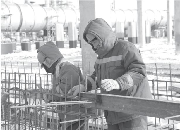
Работники ТОО «Юниксстрой» устанавливают арматурные каркасы железобетонных лотков
