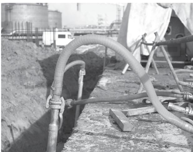
Откачка грунтовых вод с помощью иглофильтров
