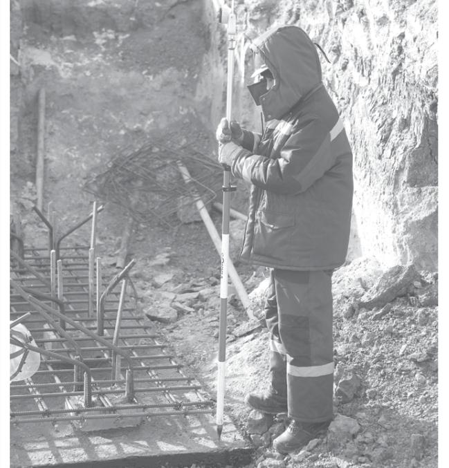
Работники ТОО «Юниксстрой» проводят геодезическую съемку бетонной подготовки
