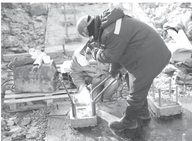
Срубка и анкерка свайных стержней (ТОО «Юниксстрой») Гидроизоляция бетонной подготовки
