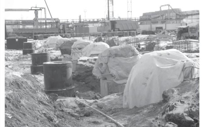
Монтаж железобетонных колодцев. Работу проводит «Евразия строй капитал - 2007»
