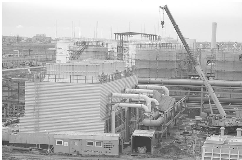
Предусмотрена подземная и надземная прокладка наружных трубопроводов свежей воды по технологической трассе. Подача очищенных стоков предусматривается по трубопроводу диаметром 250 мм, изготовленных из стальных электросварных труб с электрообогревом и изоляцией. Для подпитки блока обратного водоснабжения будут использоваться очищенные сточные воды после фильтрации и обеззараживания. Качество очищенных сточных вод позволит использовать обработанную воду для подпитки оборотных систем.
