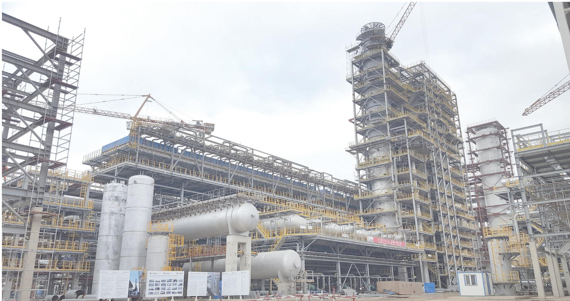
На строительной площадке комплекса глубокой переработки нефти на Атырауском НПЗ продолжается работа по поставке и монтажу технологического оборудования, трубопроводов на объектах КФ «Sinoproc Engineering (Group) Co. LTD».
