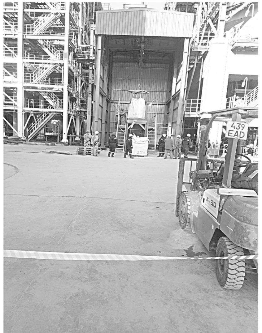
На фото: процесс загрузки катализатора на установке каталитического крекинга
