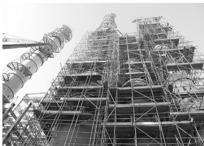
Монтажные работы площадок обслуживания колонного оборудования
