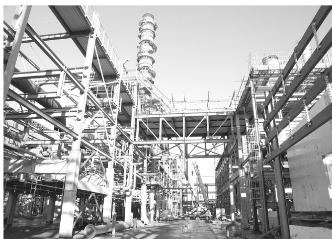
Монтажные работы металлоконструкций установки PX
