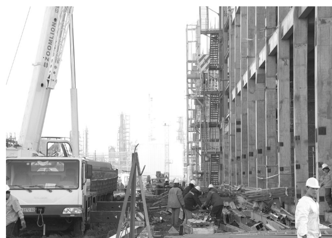
Монтажные работы площадок обслуживания
