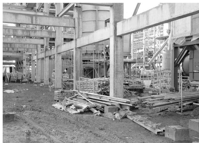
Строительные работы на эстакаде
