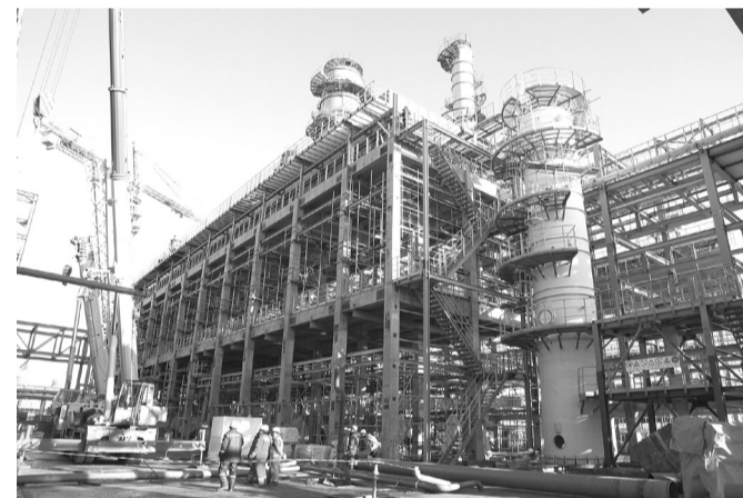
Строительно-монтажные работы этажерки №1 установки CCR
