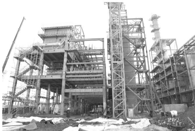
Земляные и бетонные работы на площадке КПА
