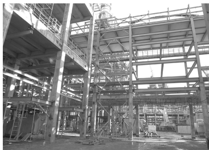
Установка площадок обслуживания
