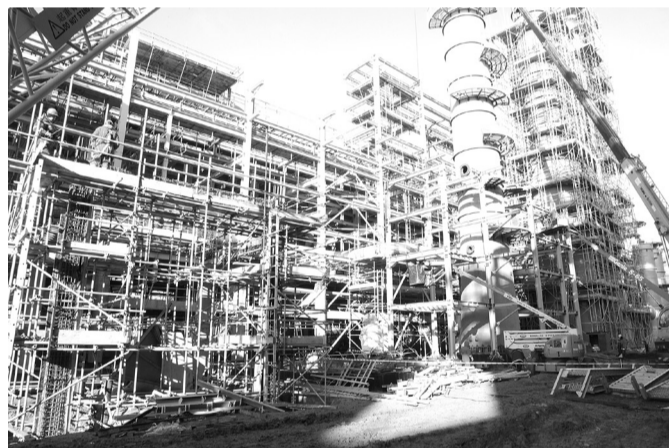
Монтажные работы металлоконструкций эстакады
